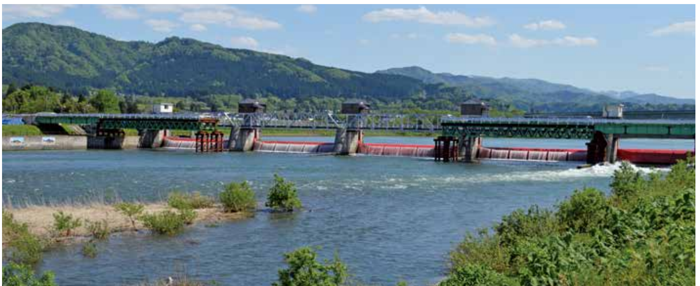
国営赤川二期事業で改修中の赤川頭首工
