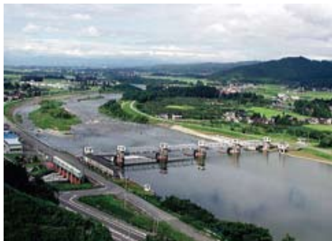
Photo: 赤川頭首工
