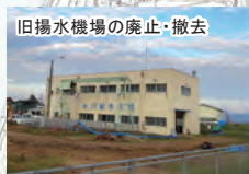
▲赤川揚水機場
