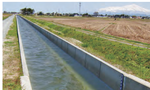
▲更新された東三号幹線用水路
