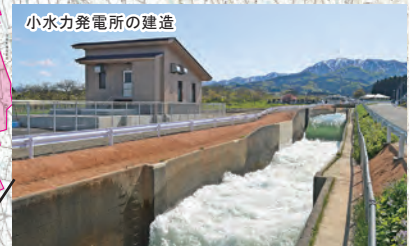
▲赤川地区小水力発電所
