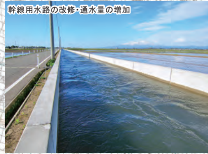
▲東三号幹線用水路
