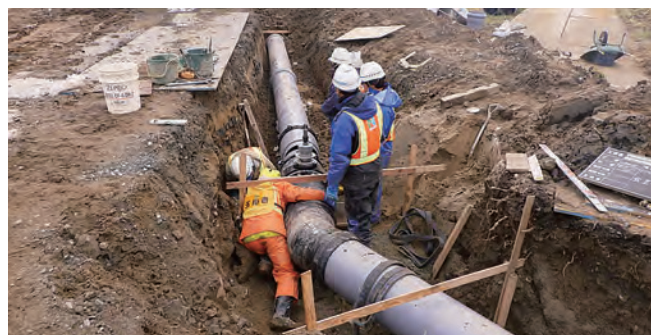
▲ 広野地区水路管路化の様子
