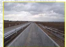
東3号幹線用水路 (二次製品改築)
