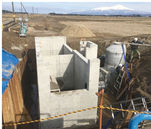
▲用水路管路化工事の様子(広野地区、R1年)
