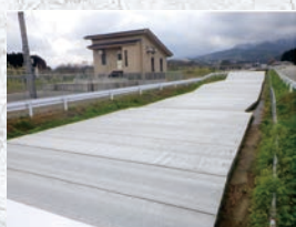
西1号幹線水路 防音対策工
