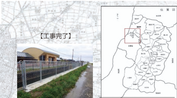
東3号幹線水路 安全施設
