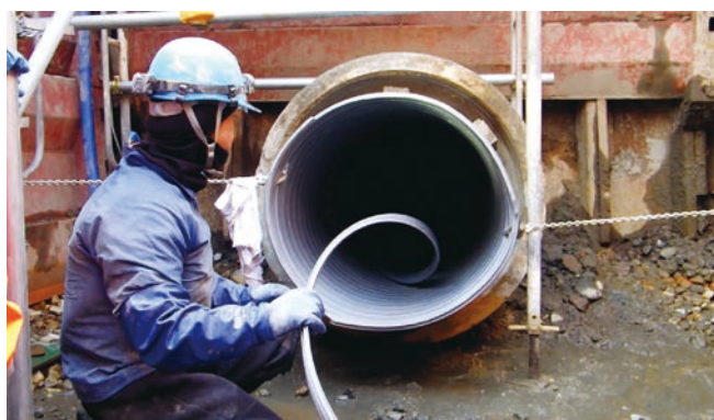
▲SPR工法によるコンクリート用水管更生の様子(田沢用水路、R1年)
