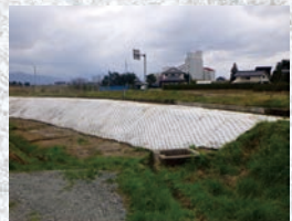
東2号幹線水路 法面保護工
