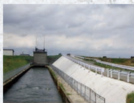
西1号幹線水路 法面保護工
