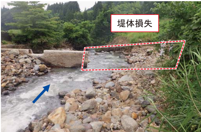
東岩本地内東岩本川（旧越中堰）豪雨による堤体損失の状況
