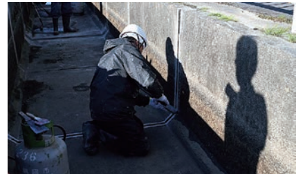
京田用水路目地補修工事
