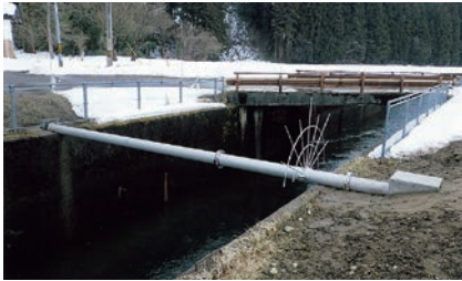
熊出地区水管橋整備補修工事
