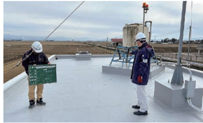
押切第1揚水機場整備補修工事
