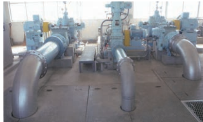
京田第4揚水機場吐出集合管交換工事
