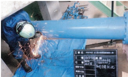
友江揚水機場整備補修工事
