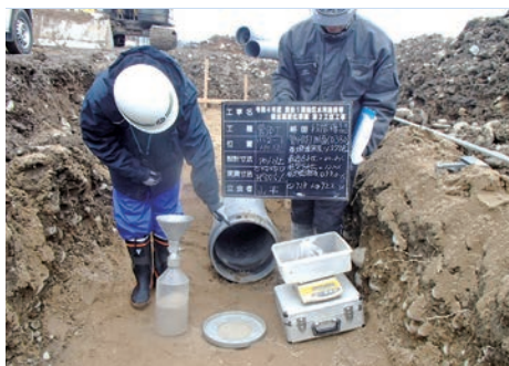
▲ 県営黄金地区事業 低圧パイプライン据付工事（青龍寺川地区）
