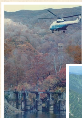
◀ 昭和62年 改修工事時ヘリ空輸状況及び工事着工前の堰柱・水門
