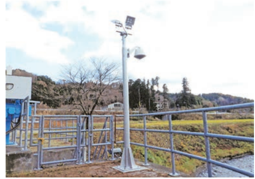
▲管野代頭首工遠隔監視カメラ設置工事（八沢川地区）
