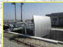
東3号幹線水路押切第1分水工
