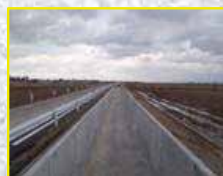
東3号幹線水路（2次製品改築）
