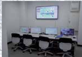
中央管理所操作室（新設）
