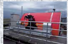
赤川サイホンラジロゲート改修
