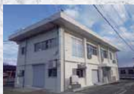
赤川頭首工管理棟改修
