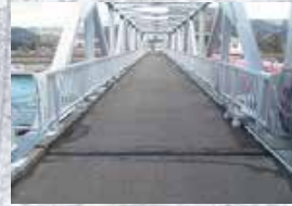
赤川頭首工管理橋更新
