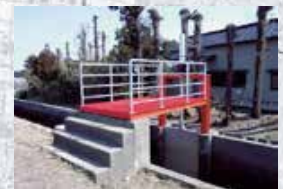
東2号幹線用水路ゲート改修
