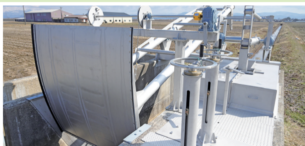
二丁堀余水吐ウォッチマンゲート更新工事
