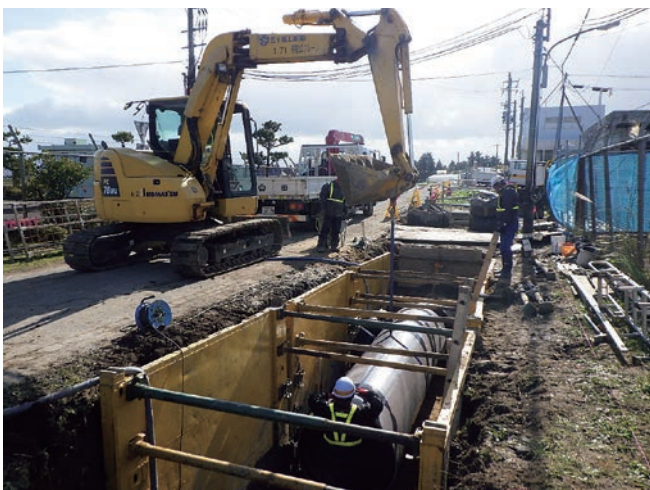
▲ 県営広野地区事業 低圧パイプライン敷設状況
