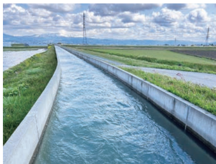
▲ 東3号幹線用水路通水状況
