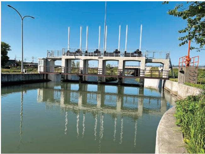
▲青龍寺川 本田分水工
